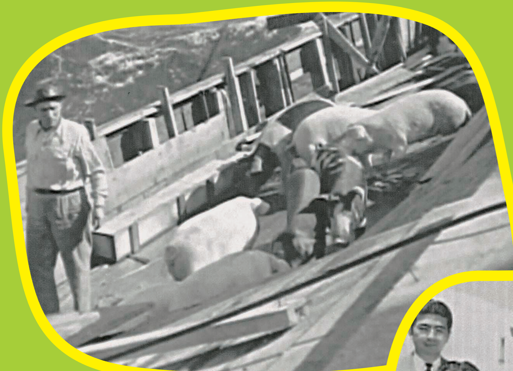
▲USSジョン・オーエン号 甲板の豚小屋 A small pigpen on the deck of the USS John Owen
